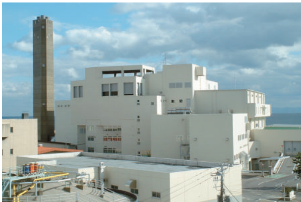
ひの で せいそう ぜんけい 日乃出清掃工場全景
